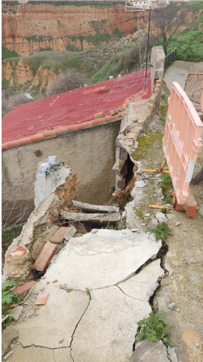
Ilustración 3 Parte superior muro vial izqda.
