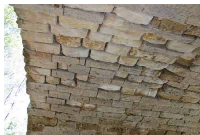
Lavado de juntas en bóveda de arco S.
