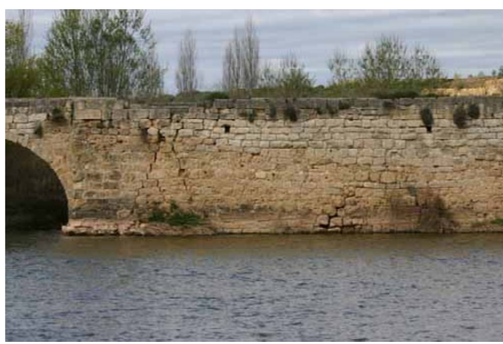
Muro del muelle entre arco S y arco R.
