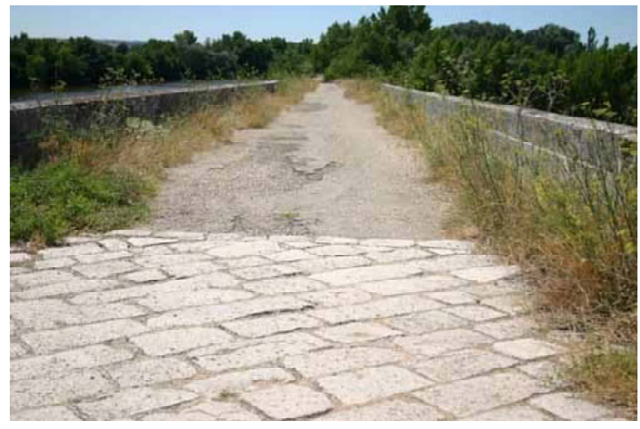
Zona enlosada del tablero del puente.
