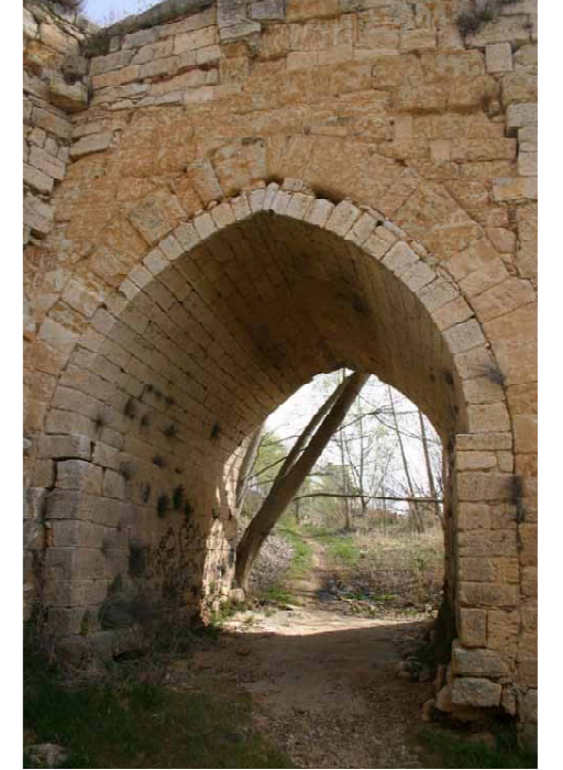
Costado de arco A forrado con doble rosca de fábrica de sillaría.
