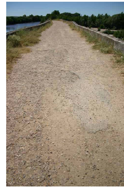
Estado del tablero del puente en mitad norte.
