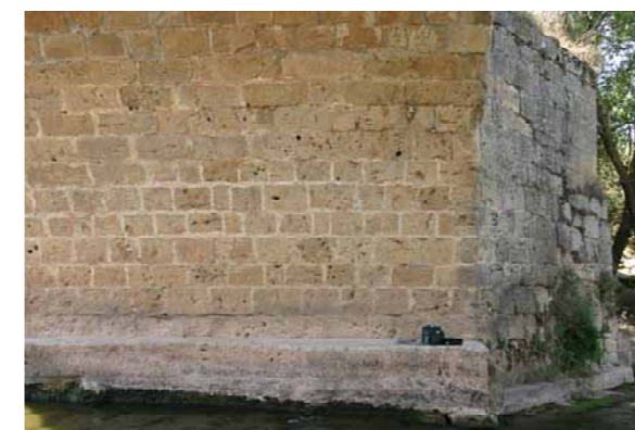
Cepa de pila entre arcos P y R desde el norte.
