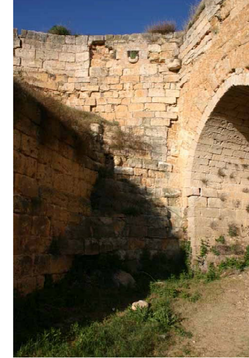
Costado de arco A forrado con doble rosca de fábrica de sillaría.
