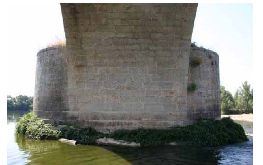
Cepa de pila entre arcos I-J desde el norte.
